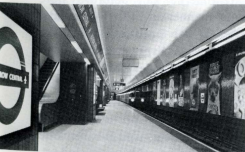
Første nye 6-vognstog med længere (fly)bagagevenlige vogne ankommer til Heathrow Central, 14 m under lufthavnens start- og landingsbaner.
